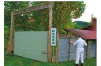
写真4-13 クマよけの囲いと電気柵を同時に設置する
